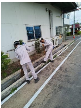
รูปที่ 25 การทำความสะอาดรางระบายน้ำรอบโครงการ
