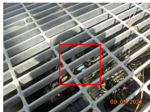
รูปที่ 20 ลูกลอยควบคุมการเดินเครื่องสูบน้ำ
